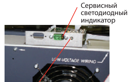
Рис. G-2. Расположение сервисной кнопки и светодиодного индикатора
